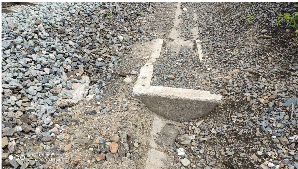
Obrázek 3. Zanesené odvodnění na TÚ
