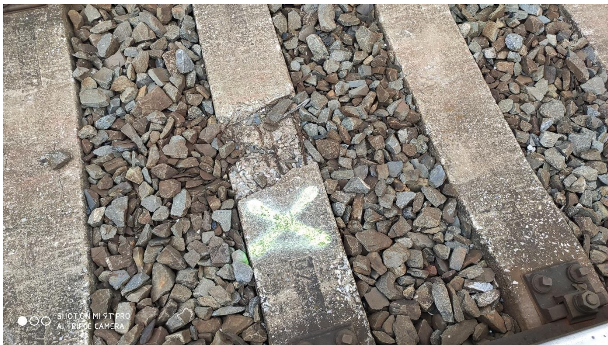
Obrázek 5. Detail poškození betonového pražce
