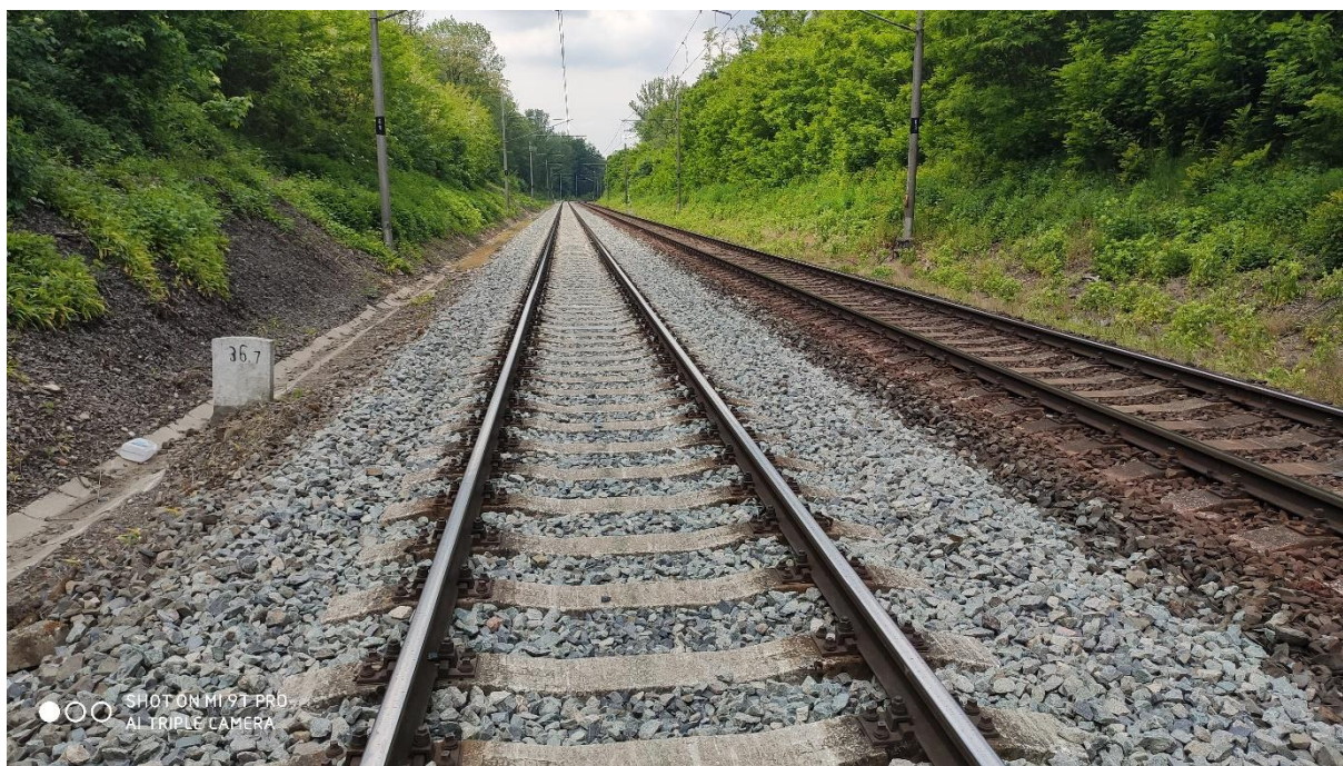
Obrázek 6. pročištěné kolejové lože od stanice ŽST Ostrava Vítkovice směrem k Odb. Odra
